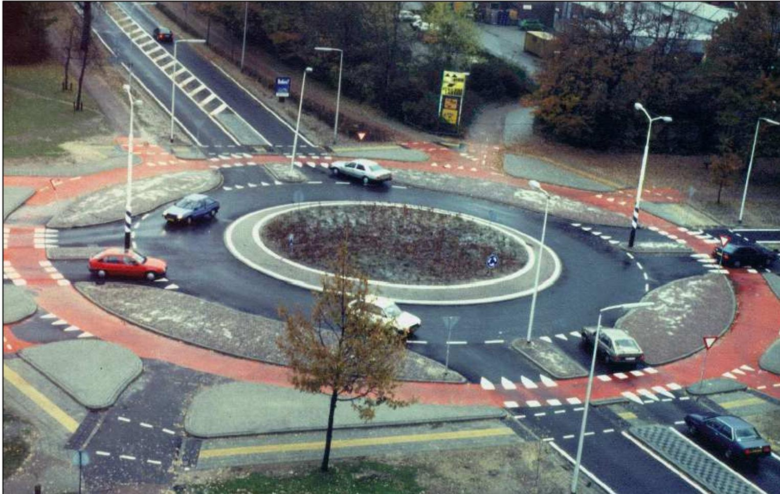
*Un esempio di rotatoria sicura per i ciclisti, in quanto la corsia ad essi destinata è ricavata all'esterno della corona giratoria, con uno spazio intermedio di fermata per le automobili in entrata e in uscita dalla rotatoria*
