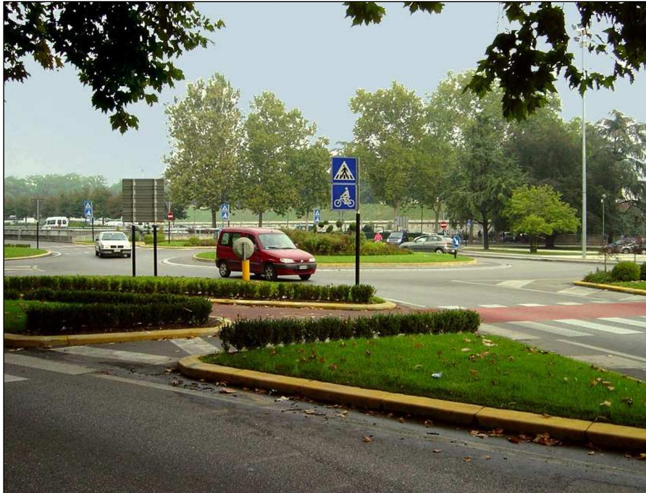
Secondo *le Norme funzionali e geometriche per la costruzione delle intersezioni stradali*, nelle rotatorie poste in ambito urbano gli **attraversamenti pedonali** devono essere arretrati rispetto all'anello e ben segnalati (arretramento di 4-5 m del passaggio pedonale rispetto al bordo esterno dell'anello rotatorio).
