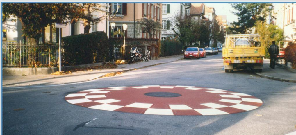
*Intersezione con calotta di bitume*
