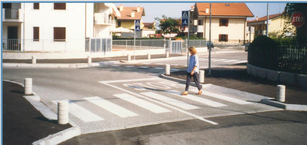
*Attraversamento pedonale con restringimento e cambio della pavimentazione*
