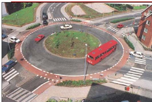
Un esempio di rotatoria potenzialmente pericolosa per i ciclisti, in quanto la corsia ad essi destinata è ricavata all'interno della corona giratoria e costituisce di fatto un ampliamento dell'anello veicolare
