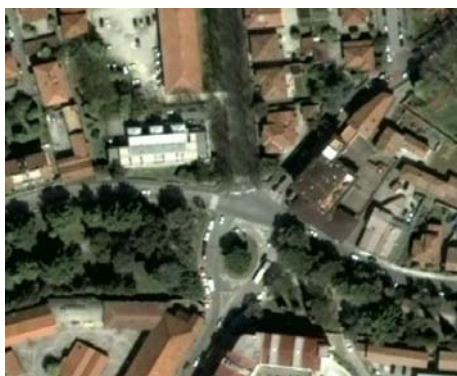
SITUAZIONE ANTE INTERVENTO
